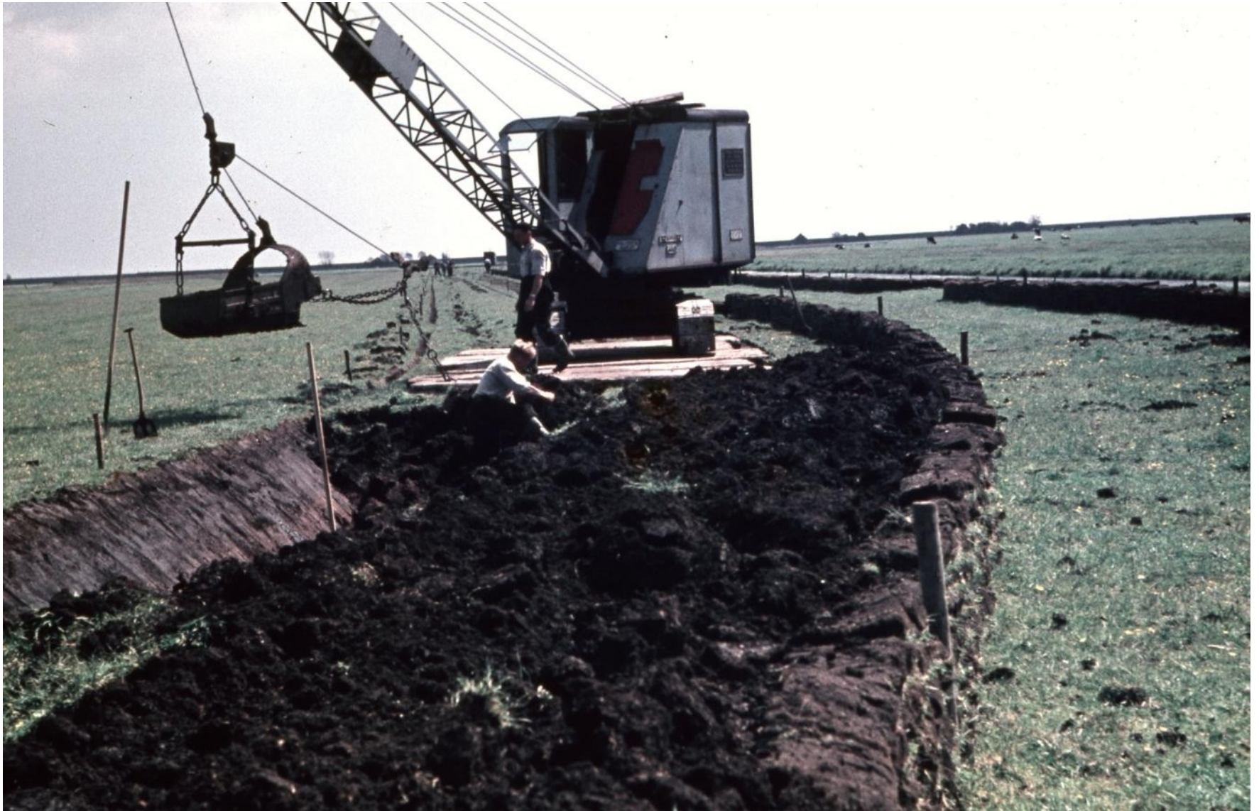
Aanleg van de Klemweg naar Warder
