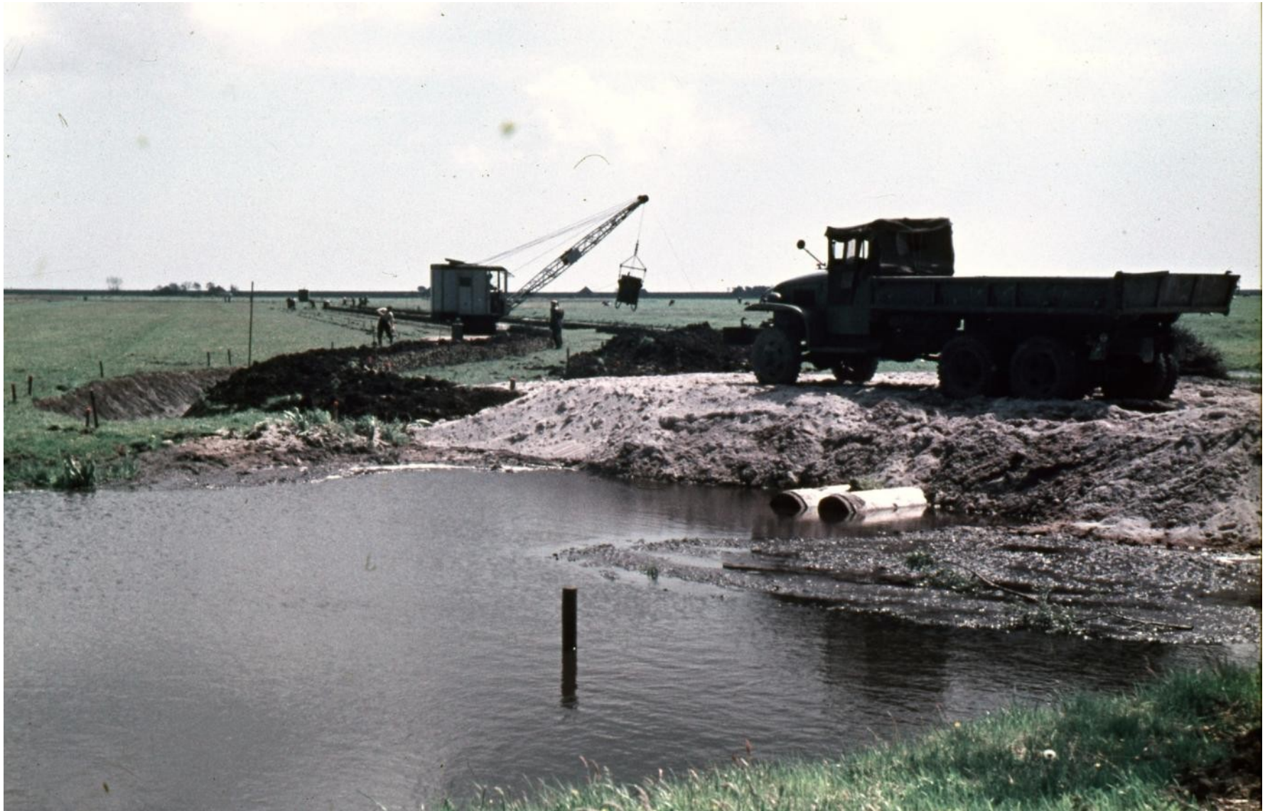
Aanleg van de Klemweg naar Warder
