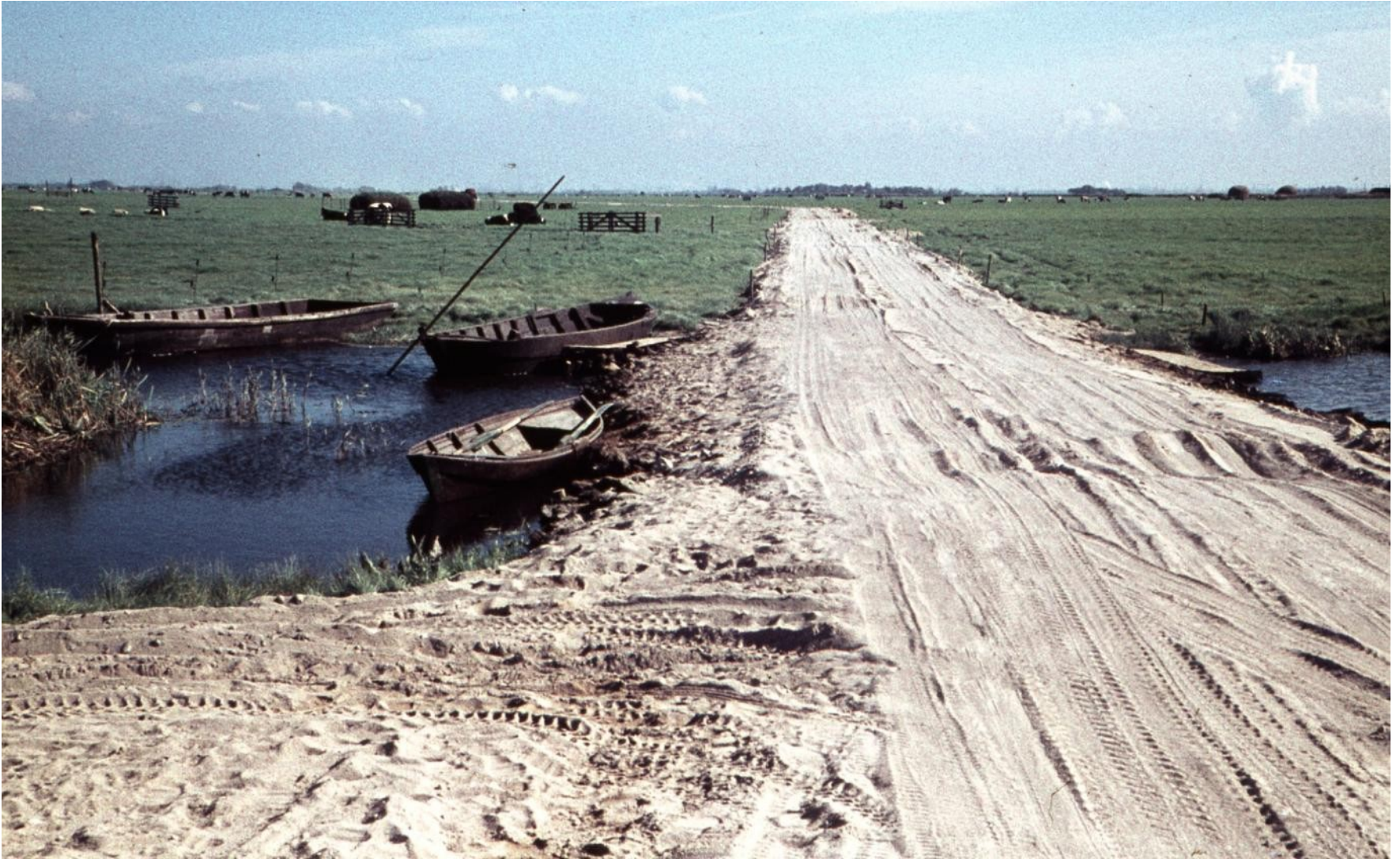
Aanleg van de Klemweg naar Warder
